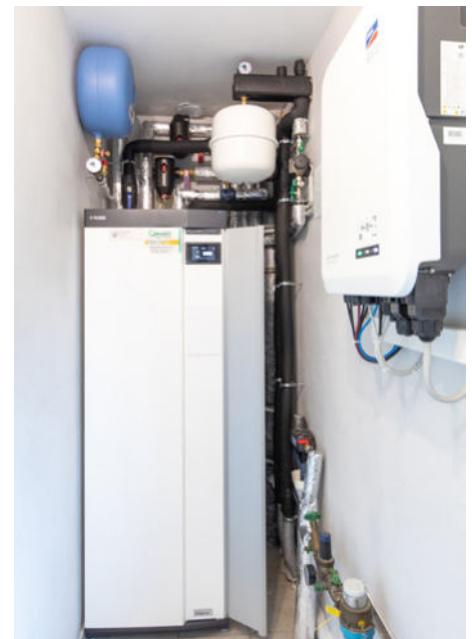
Sole/Wasser- Wärmepumpen
